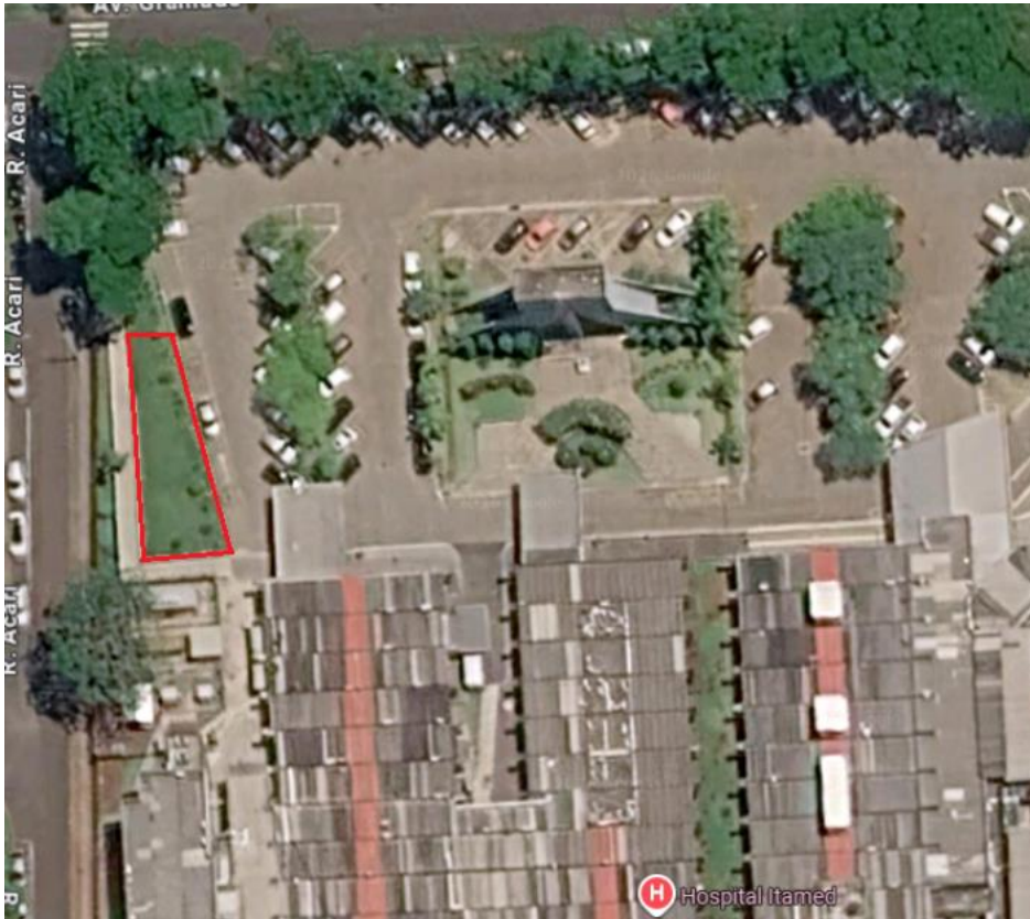
Figura 1A - Localização prevista para implantação do Datacenter Modular, na quadra do hospital, próxima à entrada lateral pela Rua Acari.
